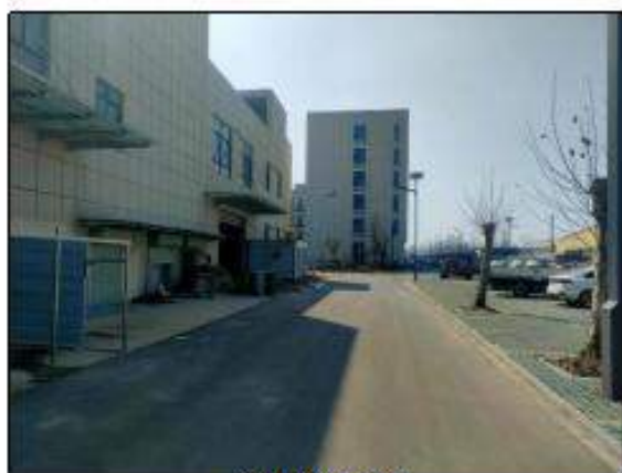
项目西侧道路
