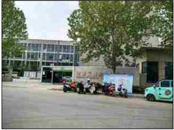
项目车间现状
