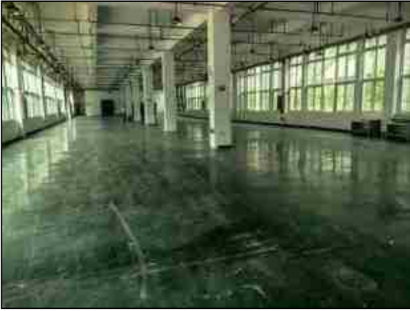
生产车间现状
