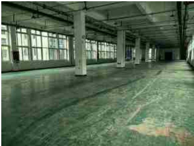
项目生产厂房内部现状
