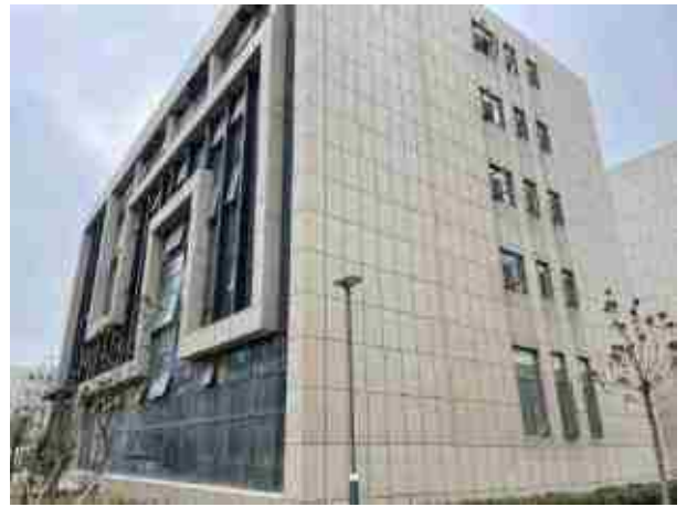
项目北侧 7 号厂房
