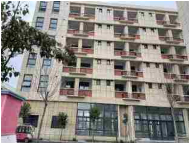
项目西侧 11 号厂房
