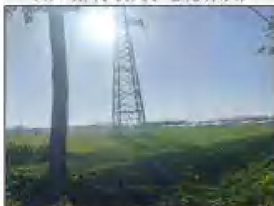
升压站占地及南侧
