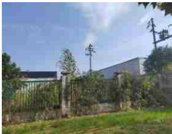
项目租用厂房北侧院墙外现状
