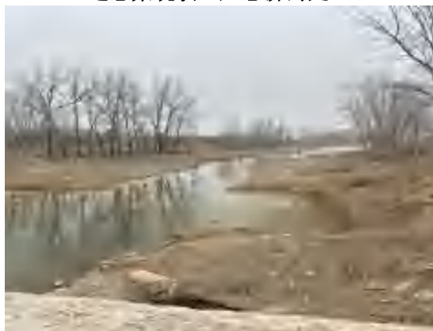
通惠渠现状（梁庄桥）
