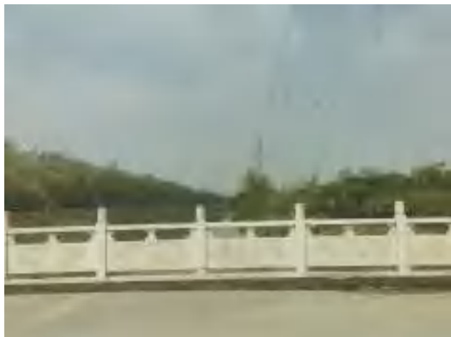
项目起点处锦绣渠
